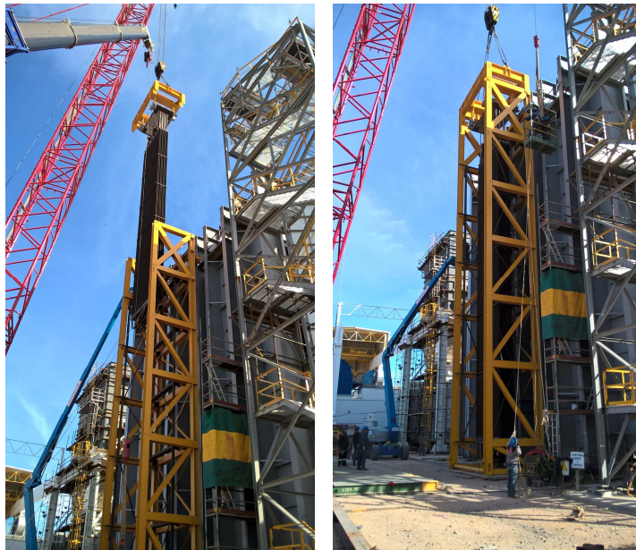
05/08/17 – Tareas de montaje de la caldera
